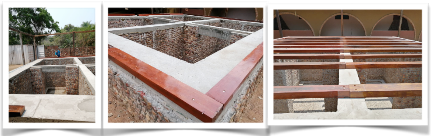
Boven vlnr: Opbouw van het houten geraamte waarop de bovenste delen van het deksel worden geplaatst.
